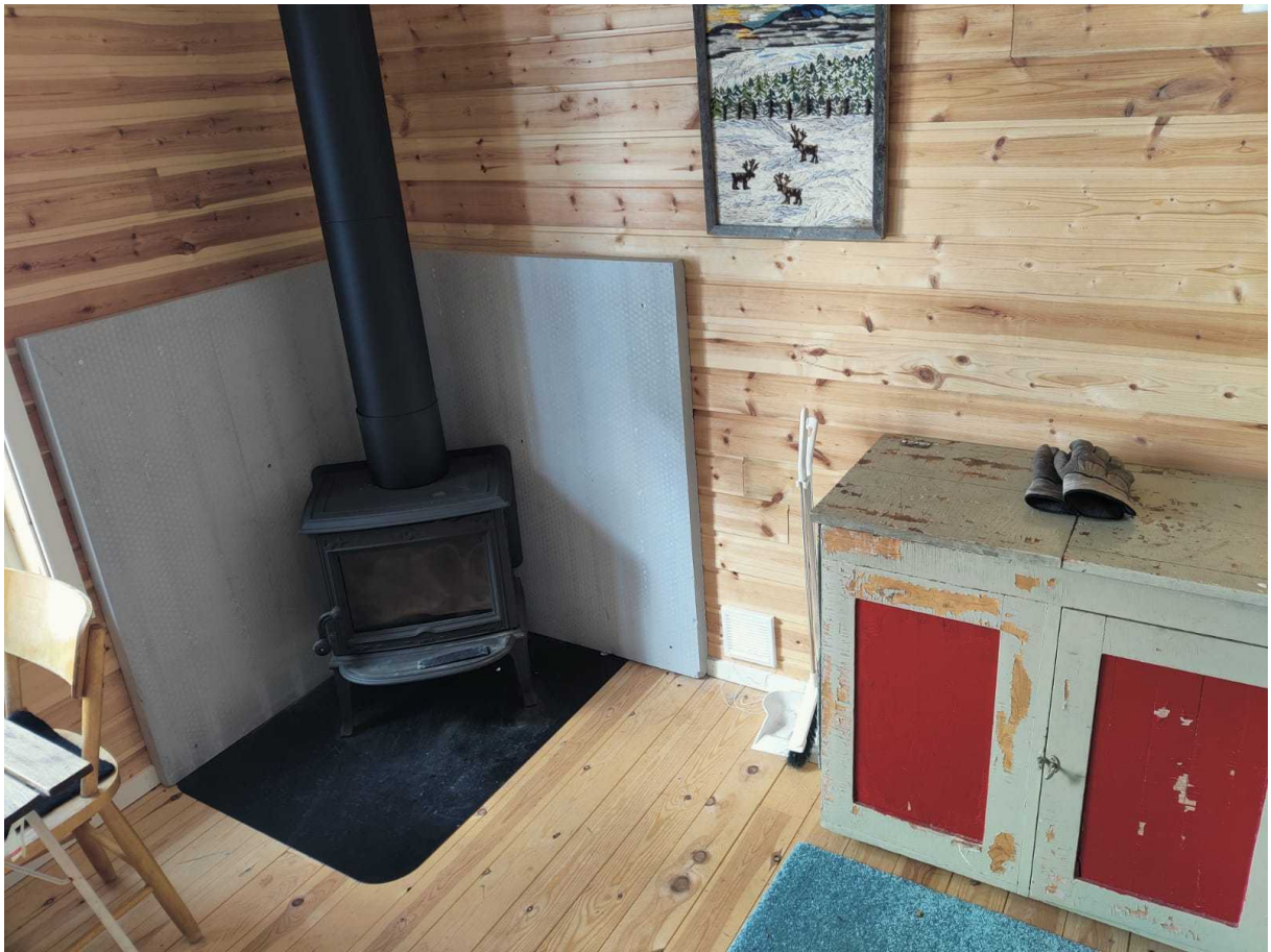
Braskamin stuga byggår 2018/2019
